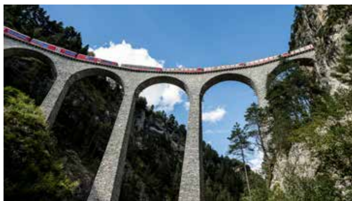
Der Landwasserviadukt ist ein vielbesuchter architektonischer Vorzeigebau.
